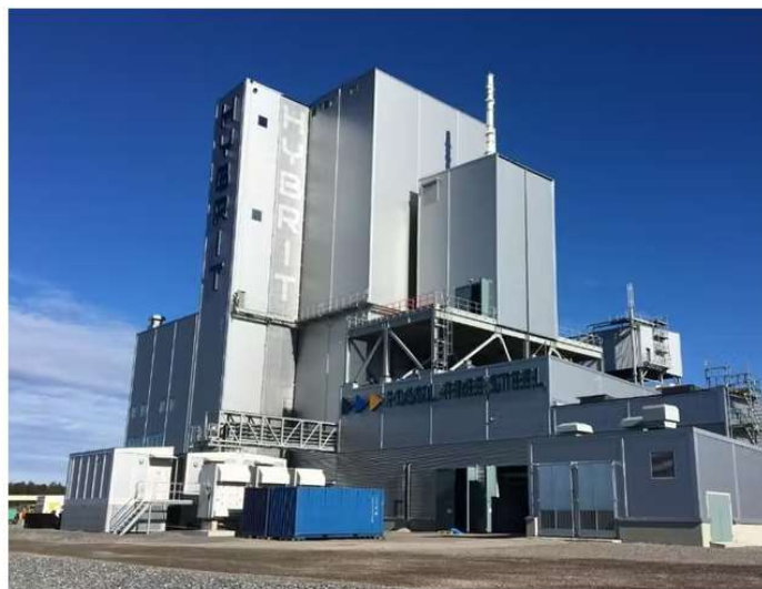
石炭の代わりに水素を使って鋼材をつくる（スウェーデンのSSABのプラント）
